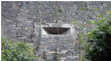
华严岗门北侧16号城墙暗堡射击口
