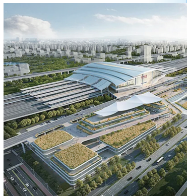
泰州高铁南站综合交通枢纽开工 图源：泰州发布
