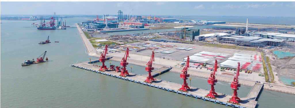
通州湾示范区高端装备临港产业园三夹沙码头上吊机林立
