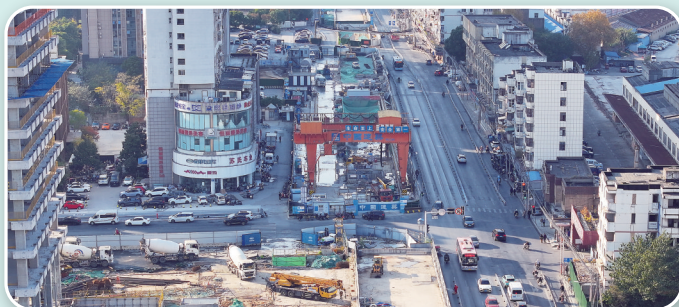
地铁9号线工程
