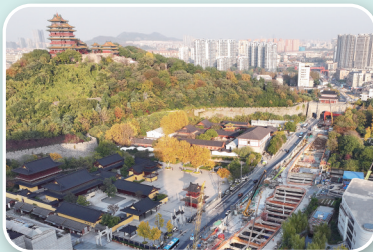
建宁西路隧道东延工程
