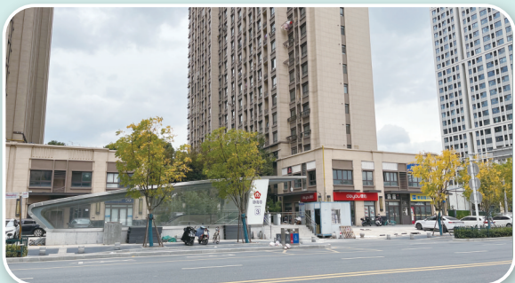
地铁5号线工程
