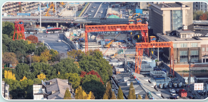
地铁9号线工程
