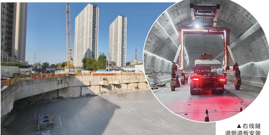
▲右线隧道烟道板安装超60%
