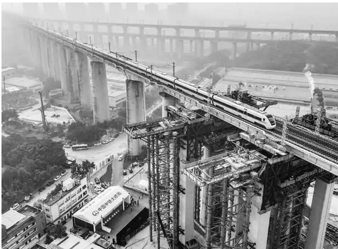
“托梁换柱”施工现场 新华社发
