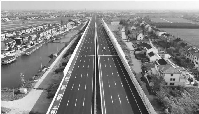
宁通高速公路扬州至南通段
