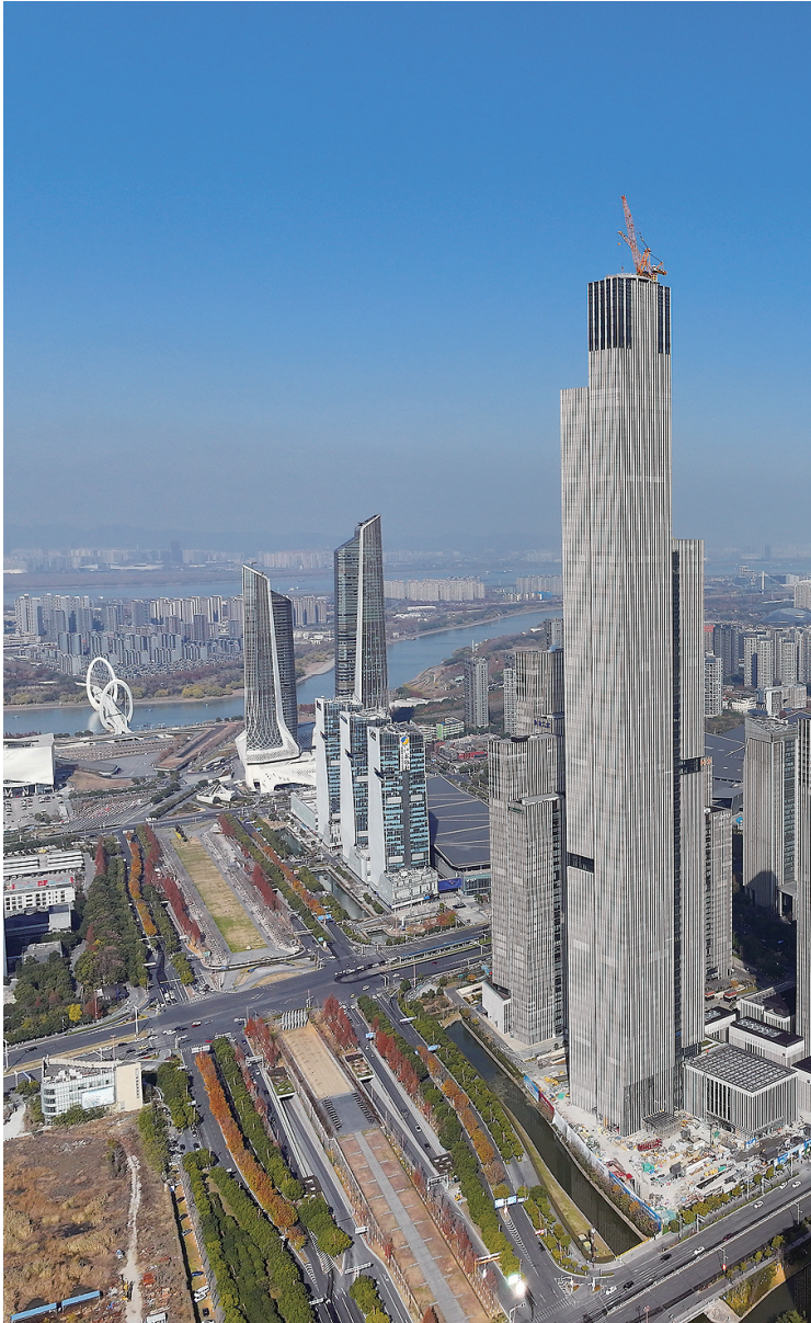
南京河西第一高楼金融城二期玻璃幕墙外立面已完成
