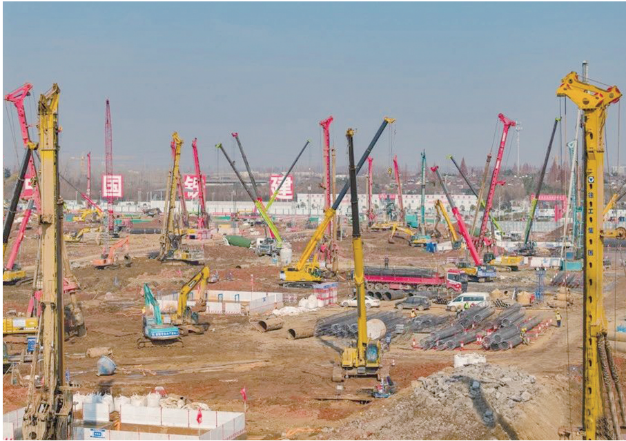
南京北站建设工地 图片据南京建设微信公众号
