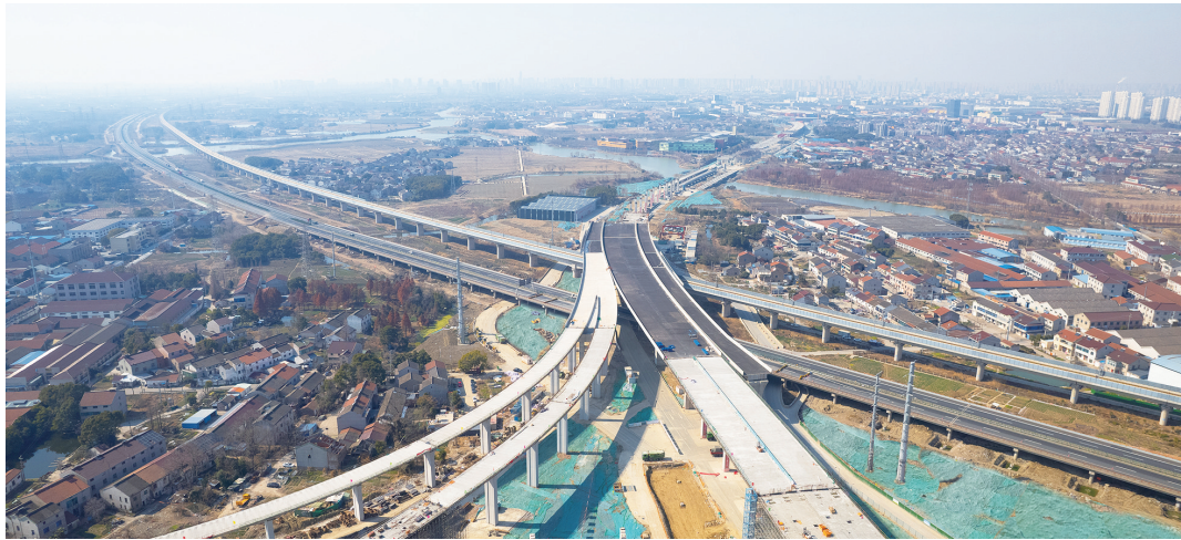
G312 快速路 SG3 标现场航拍图 通讯员供图
