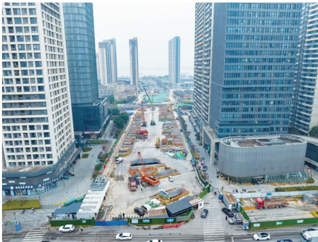
惠民大道段层板施工冲刺 图片来源:南京建设公众号
