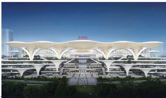
苏州北站综合枢纽工程
