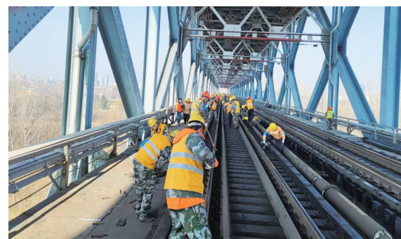
京沪线开启为期38天集中修施工 通讯员供图
