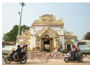
缅甸曼德勒倒塌的建筑 新华社发
