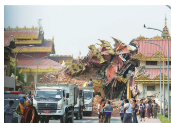
缅甸曼德勒倒塌的建筑 新华社发
