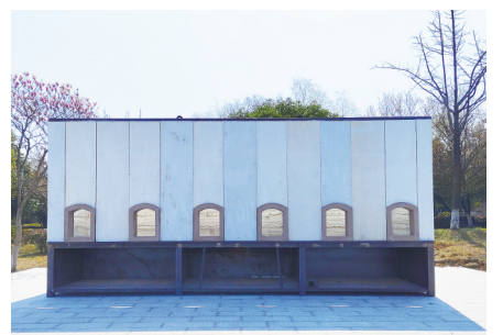
试点启用集中焚烧点
