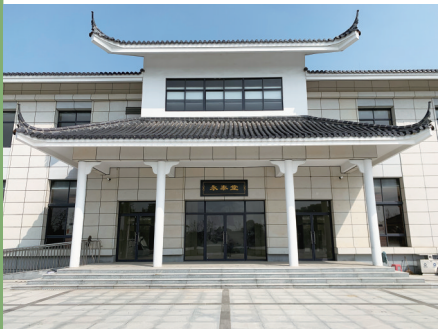
永泰园骨灰堂
