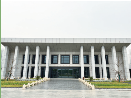
花山殡仪馆新馆服务大厅
