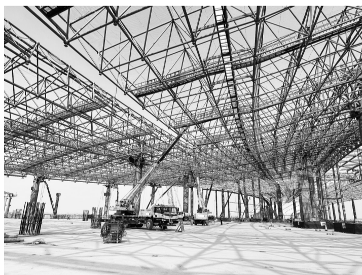
扬泰机场 T2 航站楼钢结构封顶 通讯员供图
