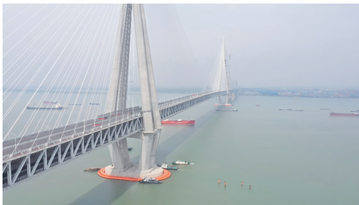
防撞设施安装完成 通讯员供图
