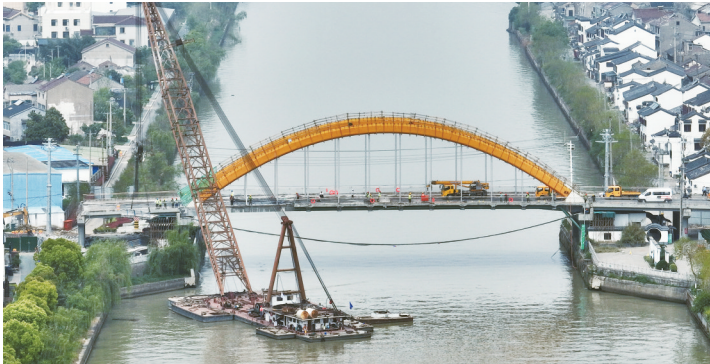
天禧桥主桥开拆 通讯员供图
