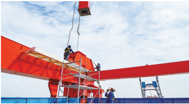
施工现场 通讯员供图
