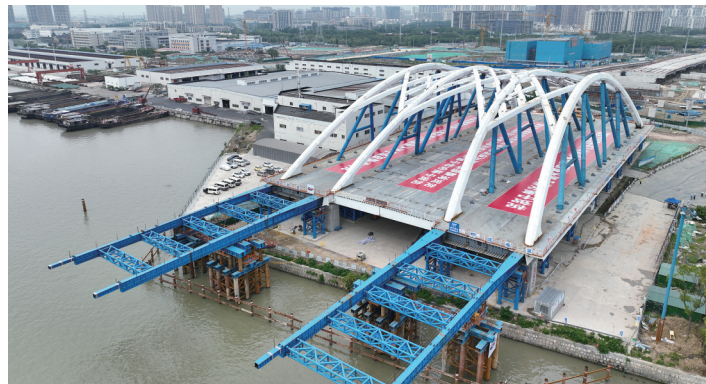
登云大桥顶推施工启动 通讯员供图
