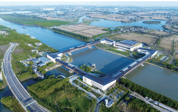
方厅水院竣工实景 图片来源:长三角生态绿色一体化发展示范区执委会
