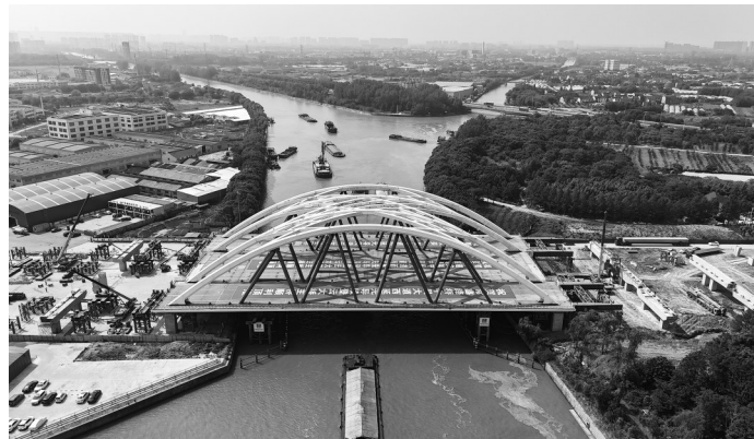
毫米级精准横跨京杭大运河 图片来源:常州交通建设
