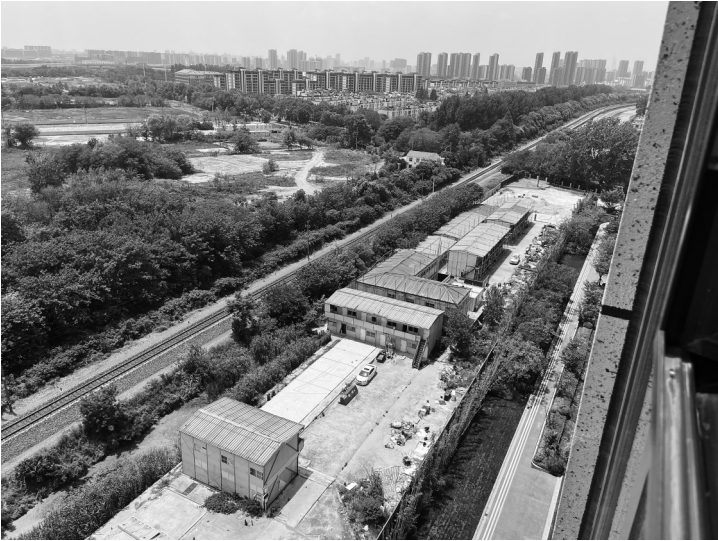
这片工棚是开发钟山峰景的施工方留下的，而工棚南面是宁芜铁路
