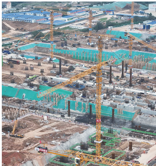
南京北站火热建设中
