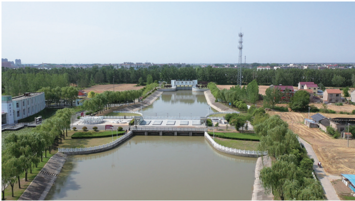
灌北泵站开启4台机组向灌云、徐圩新区等地供水 通讯员供图
