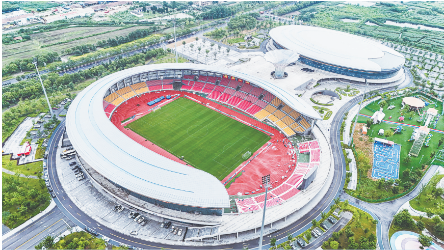
南通足球训练中心海门基地
