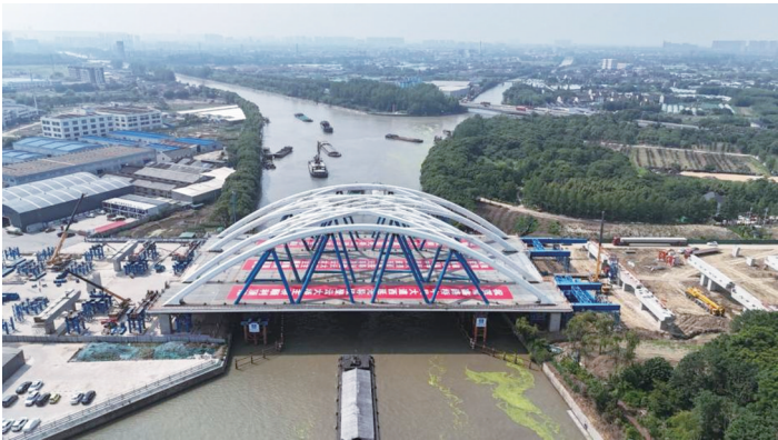
登云大桥已完成中跨顶推施工 常州交通供图
