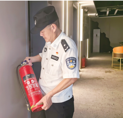
社区民警谈捍国检查消防器材 武进公安供图
