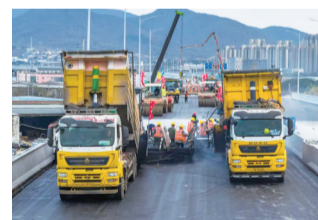
施工现场 通讯员供图
