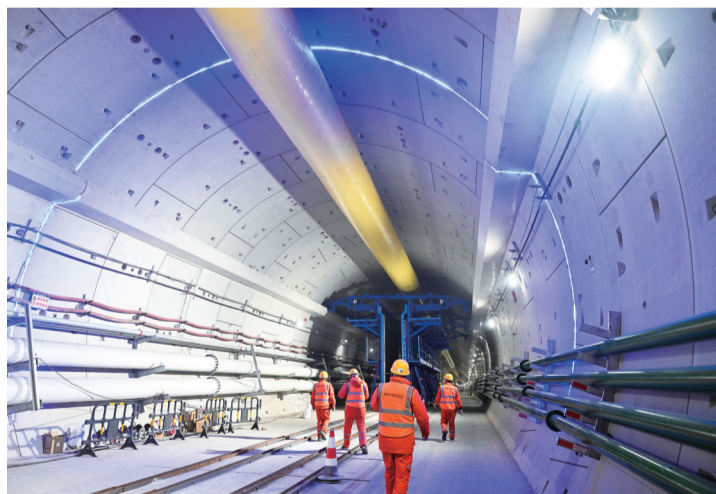
12月27日南京地铁4号线二期过江隧道内部 新华社发
