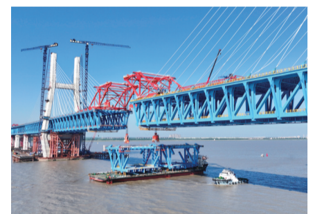
崇启公铁长江大桥南北两岸钢梁即将“握手”
