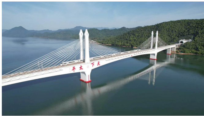
G8388次列车驶过池黄高铁太平湖特大桥 上铁集团供图
